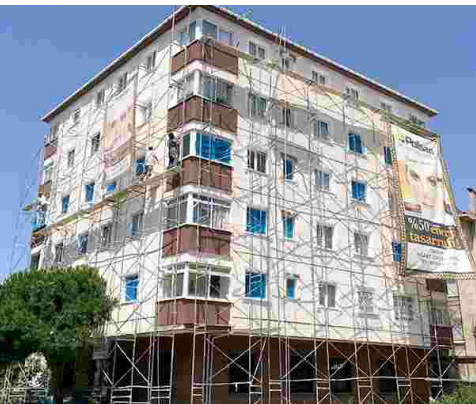
Karayolları Gül Apartmanı
